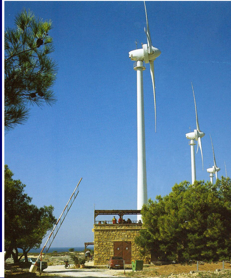
Bozcaada RES, 10.2 MW
